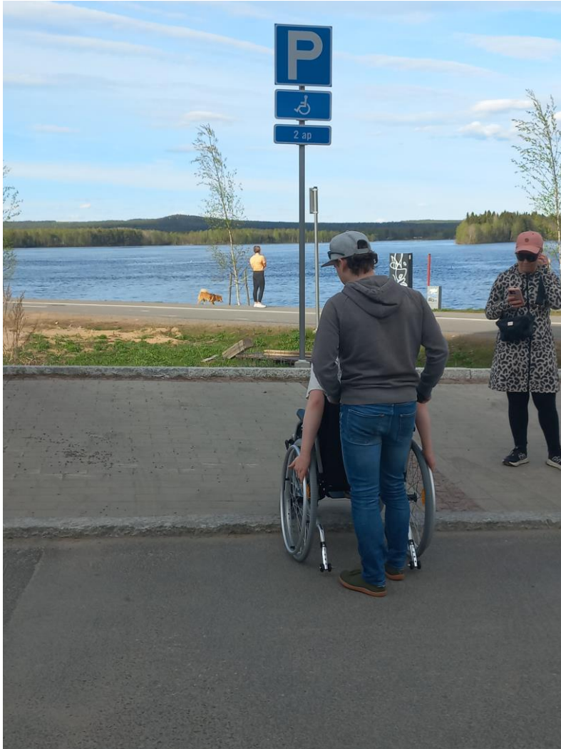
Korkea ja terävä reunakivi invapysäköintipaikalla aiheuttaa haastetta itsenäiselle liikkumiselle pyörätuolilla.
