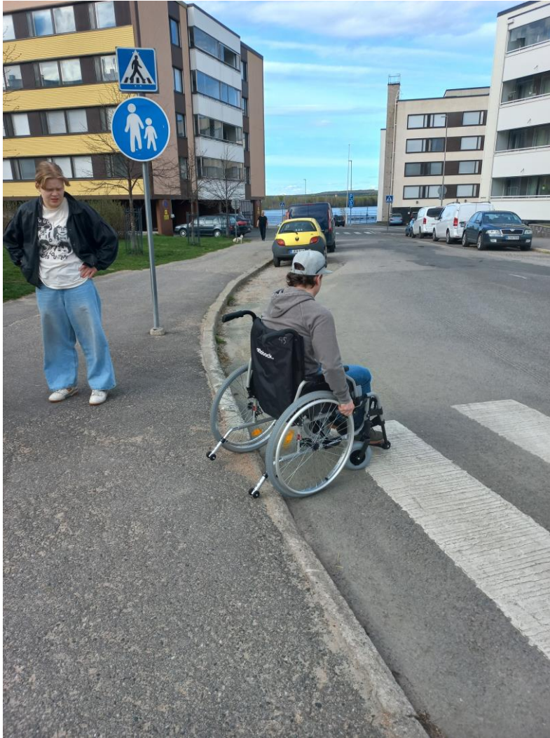
Suojatien reunalla korkea ja terävä reunakivi teki pyörätuolilla liikkumisen vaikeaksi. Kaupunginvaltuutettu Mikko Riikola havainnoi ympäristöä apuvälinettä käyttävän näkökulmasta,
